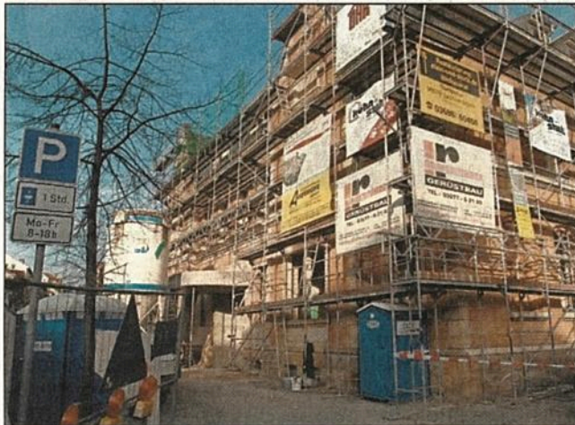
Derzeit ist das Haus noch voll eingerüstet.
