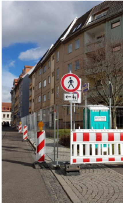
Aufstellen des Bauzaunes
