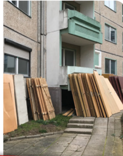
Entkernung: ausgebaute Keller- und Innentüren
