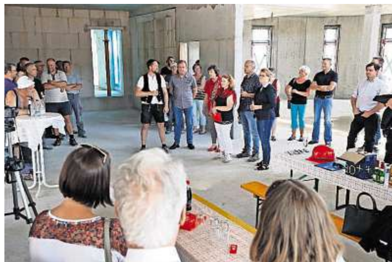
Im Anbau des Sparkassenneubaus an der Zella-Mehlis Hauptstraße hatten sich am Montag zum Richtfest Bauleute, Planer, Vertreter der Stadt Zella-Mehlis und natürlich die Bauherren eingefunden.
