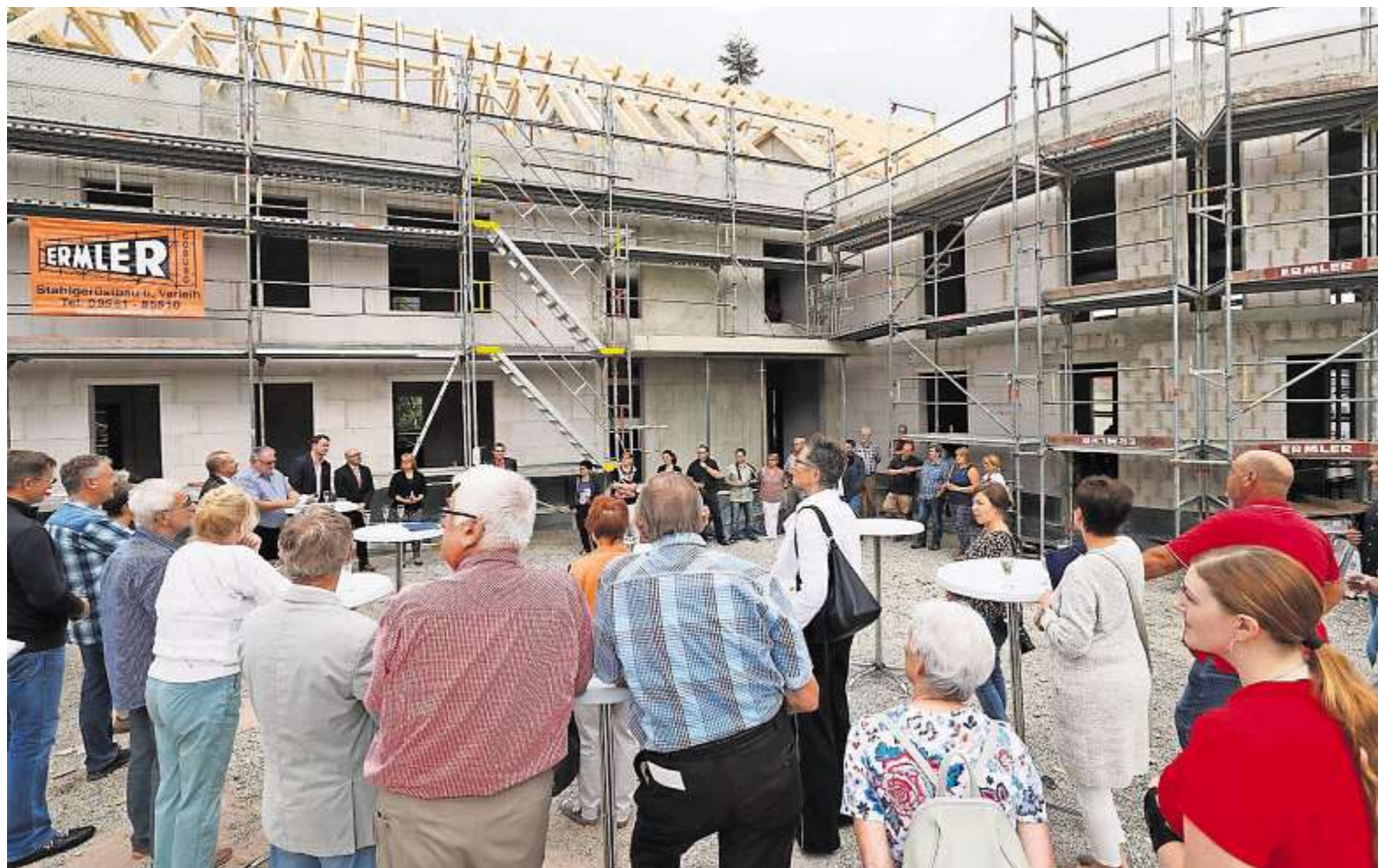
Großer Bahnhof herrschte am Neubau des Seniorenwohnprojekts der AWO in Zella-Mehlis. Dem Gebäude wurde das Richtbäumchen aufgesetzt.
