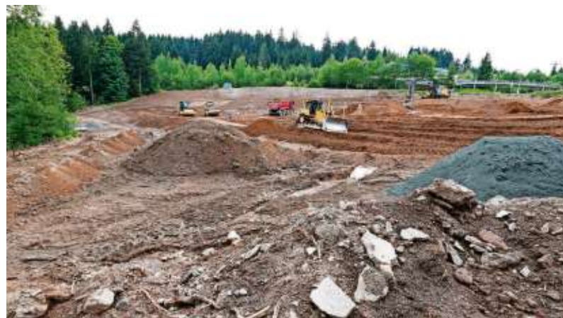
Die Fläche für den Schneiteich wurde gerodet und aufgegraben. Zur Abdichtung soll eine spezielle Folie verlegt und verschweißt werden. Weil es aber Probleme mit der Verdichtung des Dammes gibt, dauern die Arbeiten länger als geplant.
