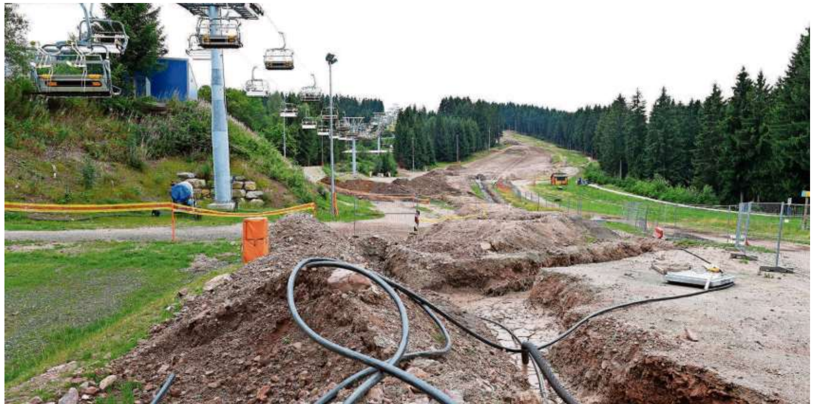
Bis Ende August werden die Tiefbauarbeiten der Firma Bock am Fallbachhang abgeschlossen sein. Dann beginnt Techno Alpin mit den Anschlüssen für die neue Beschneigungsanlage, zu der mobile Schneekanonen und festinstallierte Schneelanzen gehören. Fotos (3): Michael Baurath
