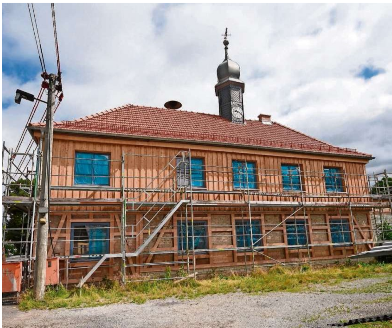
Soll im September eingeweiht werden: An der Alten Schule Wallrabs laufen gegenwärtig noch Sanierungsarbeiten.
