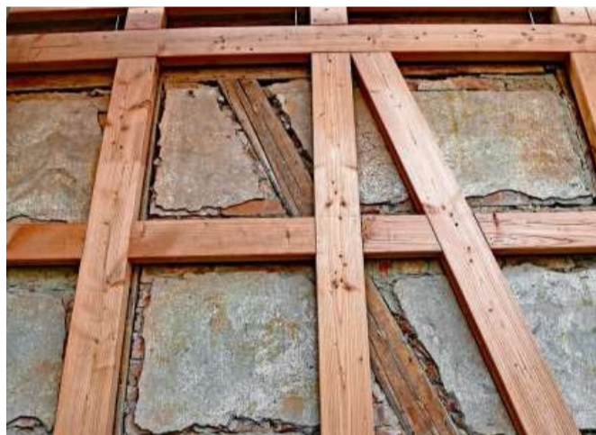
Vorgeblendet: Das Gebäude soll eine Fachwerkansicht haben. Handwerker werden die Zwischenräume verputzen.
