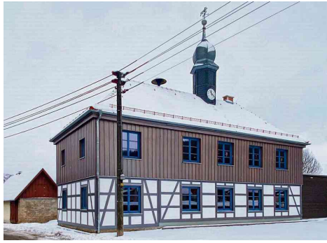
Sanierung fast abgeschlossen: die Alte Schule in Wallrabs.
